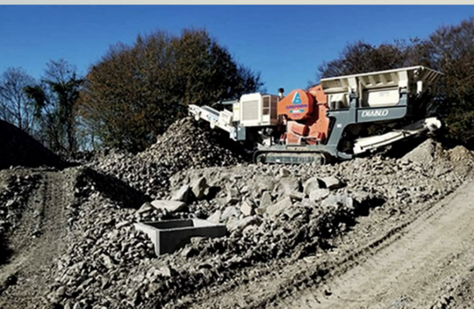
Gioigo di Corella - Lavori sul crinale per l'impianto eolico industriale
